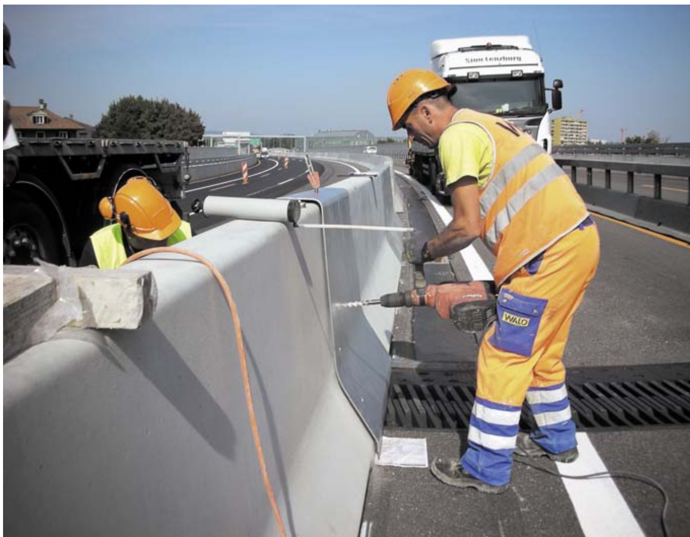
2 | Die Stahlhaube wird an der Dilatation montiert.
